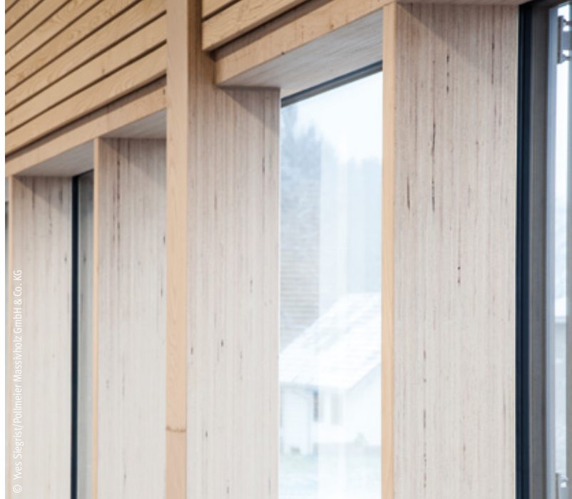
Buchenholzprodukte bieten Chancen im konstruktiven Bereich
