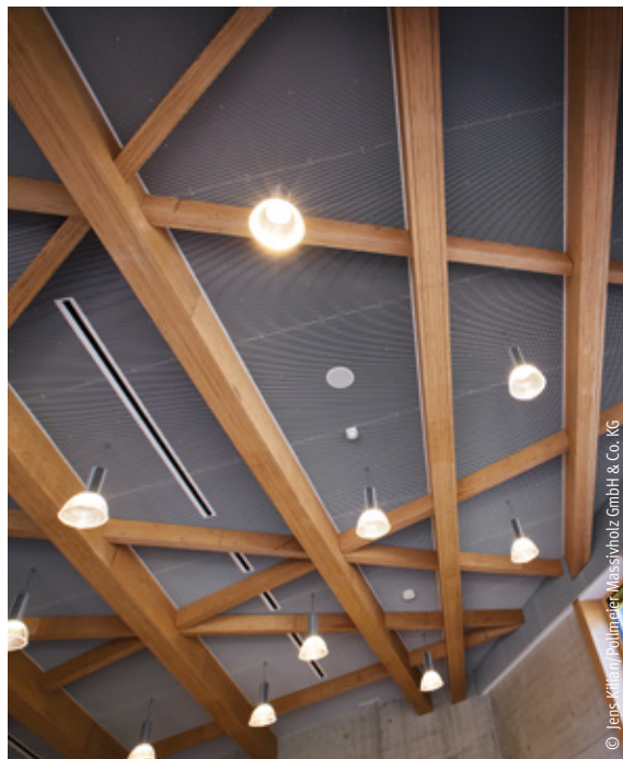
Sichtbare Balkendecke mit Baubucheträgern
