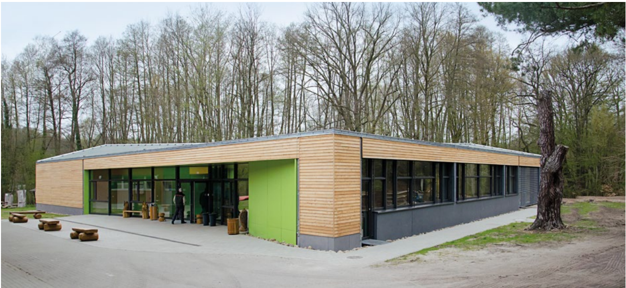
Das neue Schulungs- und Seminargebäude des Forstlichen Bildungszentrums (FBZ) in Magdeburgerforth wurde im April 2019 dem Land Sachsen-Anhalt übergeben. Das Land unterstreicht damit sein Bekenntnis zum nachhaltigen Bauen mit Holz.
